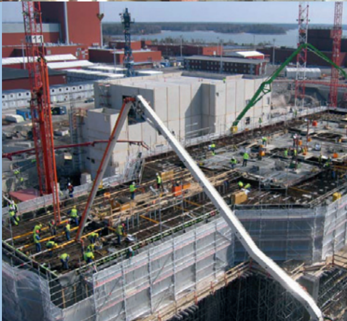
Siemens, Olkiluoto 3, Finland
